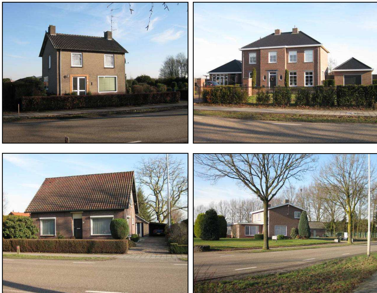
Figuur 15: Foto's bebouwing omgeving Lieropsedijk 28
