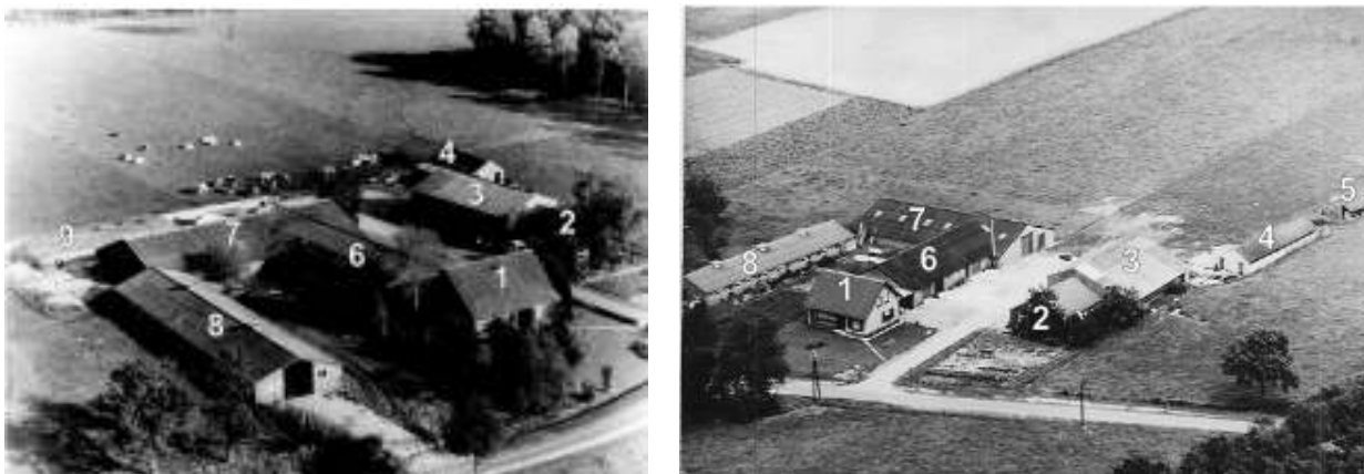
Figuur 4: luchtfoto oorspronkelijke situatie agrarisch bedrijf
