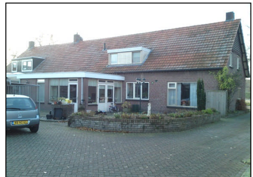
Foto's bestaande situatie
