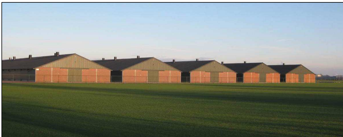
Figuur 12. Huidige situatie locatie Zandstraat 99.
