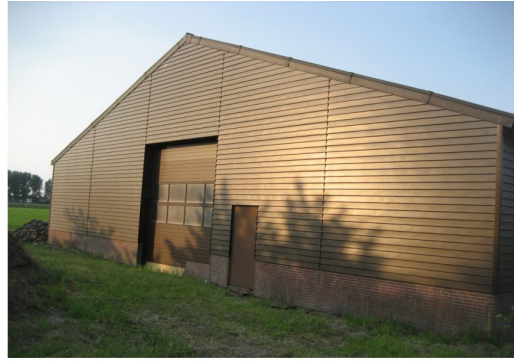
Voorzijde bestaande hal
