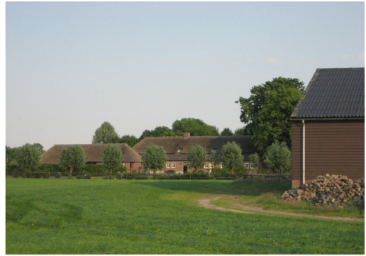
Zicht op woonboerderij en schuur (Boomen 9)
