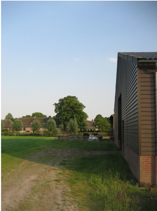
Achterzijde bestaande hal
