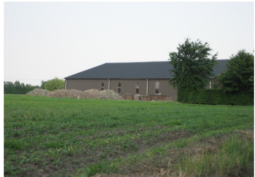
Gevelbeeld van de bestaande hal
