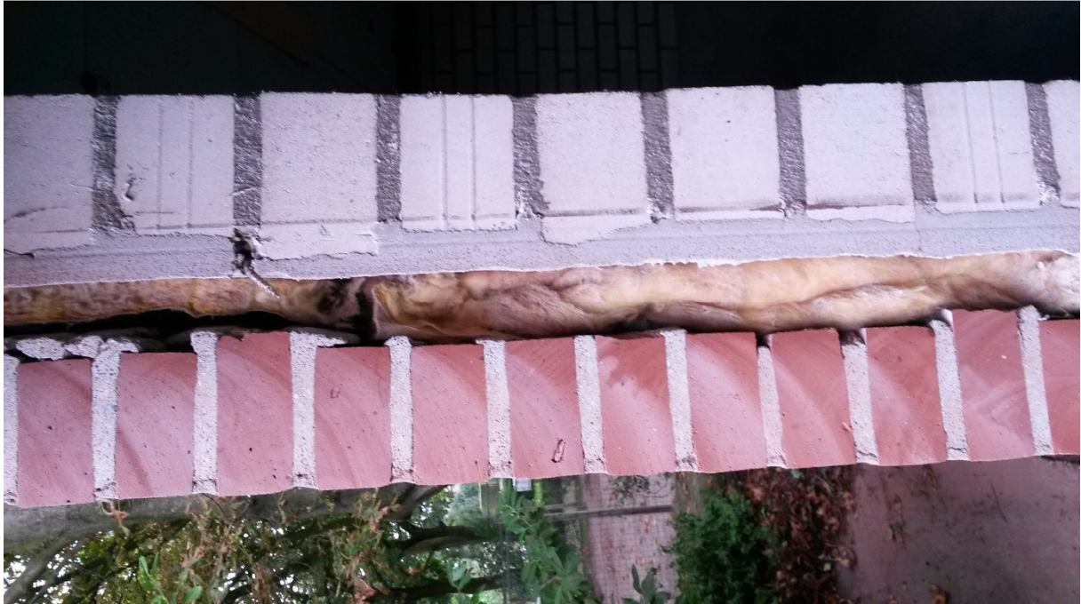
Foto: opbouw wand
