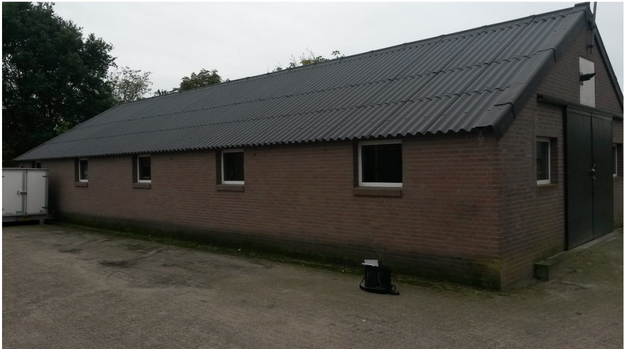
Foto: dak buitenzijde en ramen
