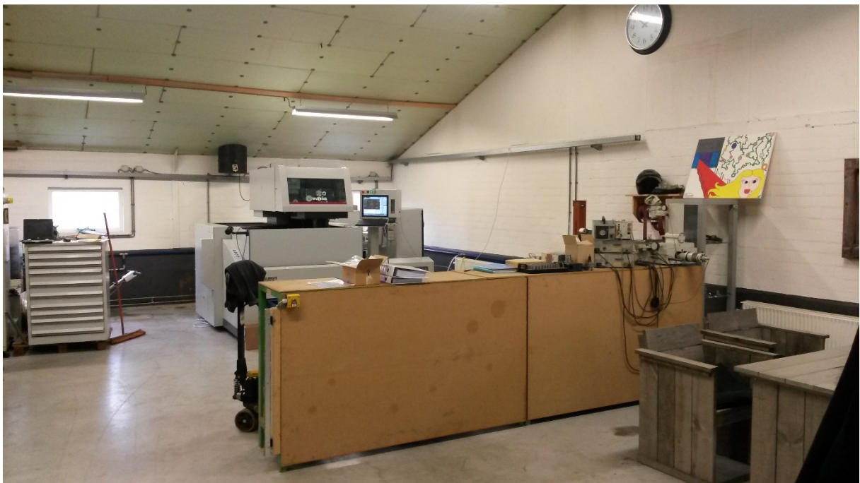
Foto: isolatie dak binnenzijde
