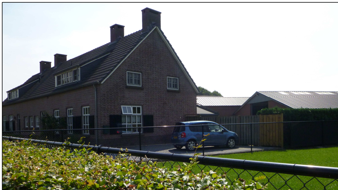
Figuur 5: Bedrijfswoning Boerenkamplaan 46 (rechtergedeelte)
