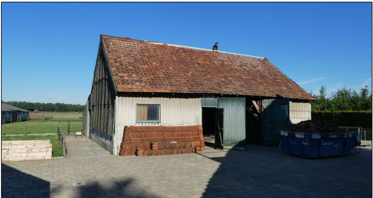
Figuur 7: Huidige schuur
