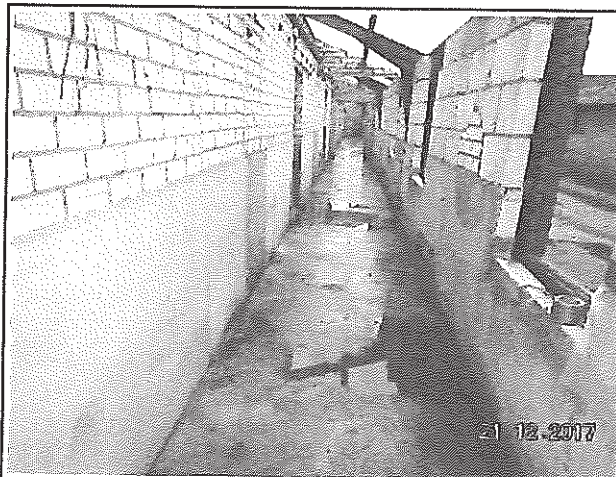
Foto 16. Gang binnenzijde stal.
