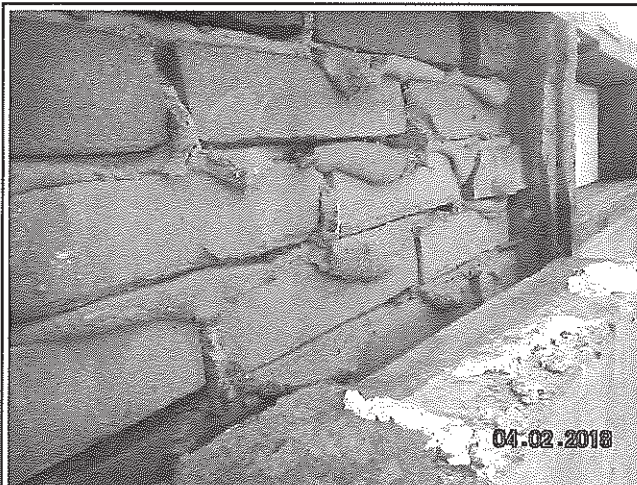
Foto 7. Naden/kieren en spouw beperkte inspectie.
