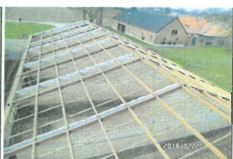
Foto 6 : nok, vloer en muur
