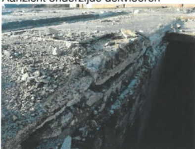
Aanzicht onderzijde dekvloeren
