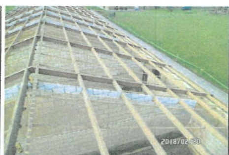
Foto 5 : dakvlak, verharding en vloer
