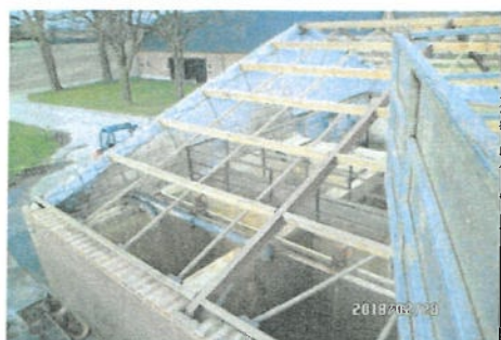
Foto 7 : dakvlak, muur en vloer
