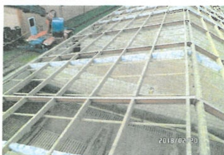
Foto 4 : dakvlak met gras en vloer
