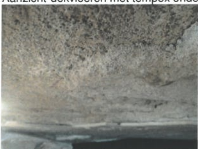
Aanzicht onderzijde mestputten
