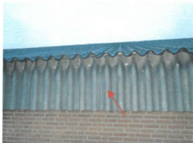
Aanzicht golfplaat, wandbeplating stal
