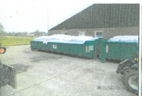
Foto 14 : verharding en containers
