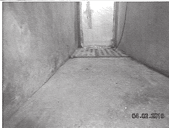
Foto 22. Inspectie vloer in de gang.
