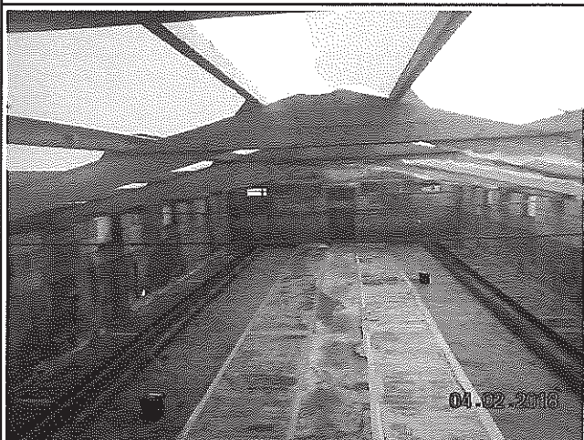
Foto 15. Inspectie van de spanten.
