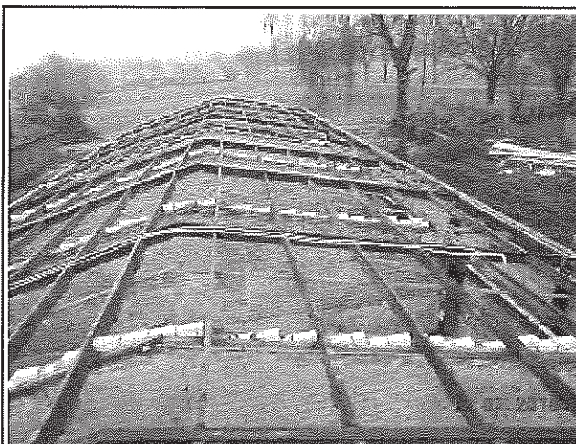
Foto 4. Overzicht dakconstructie stal 5 waar bron 6 is verwijderd.
