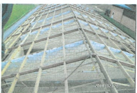
Foto 9 : dakvlak en vloer
