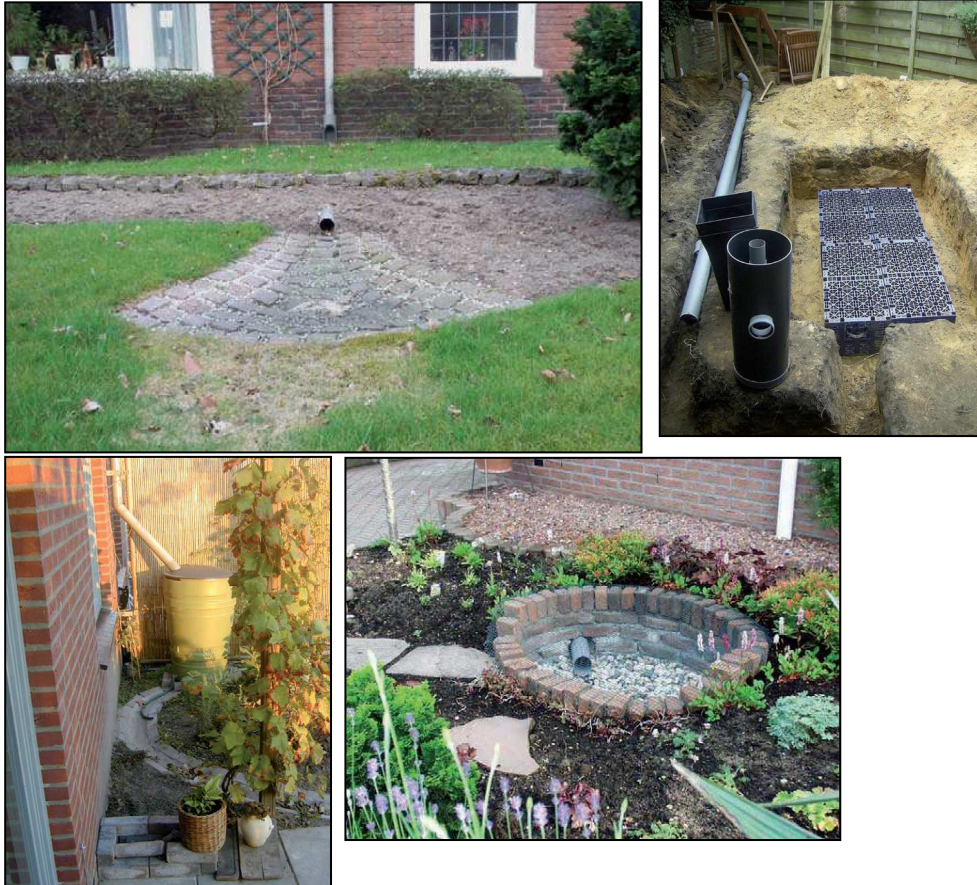
Figuur 18. Voorbeelden van infiltratiemogelijkheden die kunnen worden toegepast
