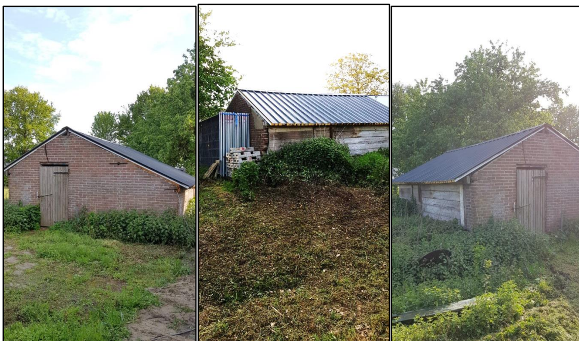
Afbeelding 9: Foto's buitenzijde te slopen schuur
