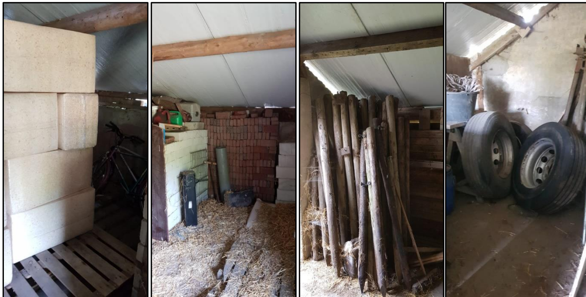
Afbeelding 8: Foto's binnenzijde te slopen schuur
