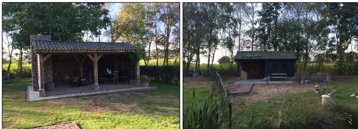
Figuur 7: Bijbehorende bouwwerken, met links de overkapping en rechts de schuilgelegenheid
