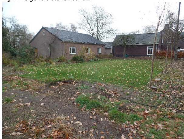
Fig.9. Zicht op aanleunwoning
