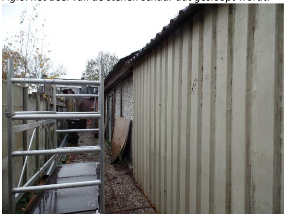
Fig.8. Achterkant van het deel van de stenen schuur dat gesloopt wordt. Vooraan metaal van het aangebouwd afdak en daarachter binnenmuur van kalksteen. Buitenmuur ontbreekt.
