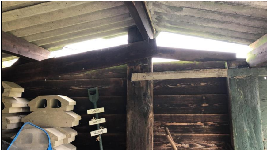
Figuur 21: Binnenkant bijgebouw
