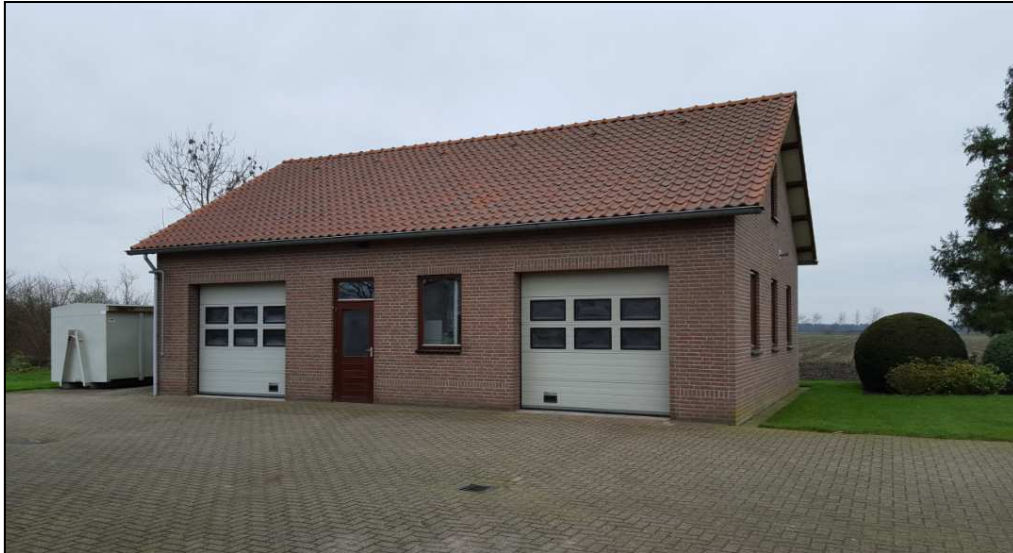
Figuur 6: Werkplaats met houtmot-installatie aansluitend hieraan, gelegen aan de achterzijde van het erf, achter de woning aan Kerkendijk 156
