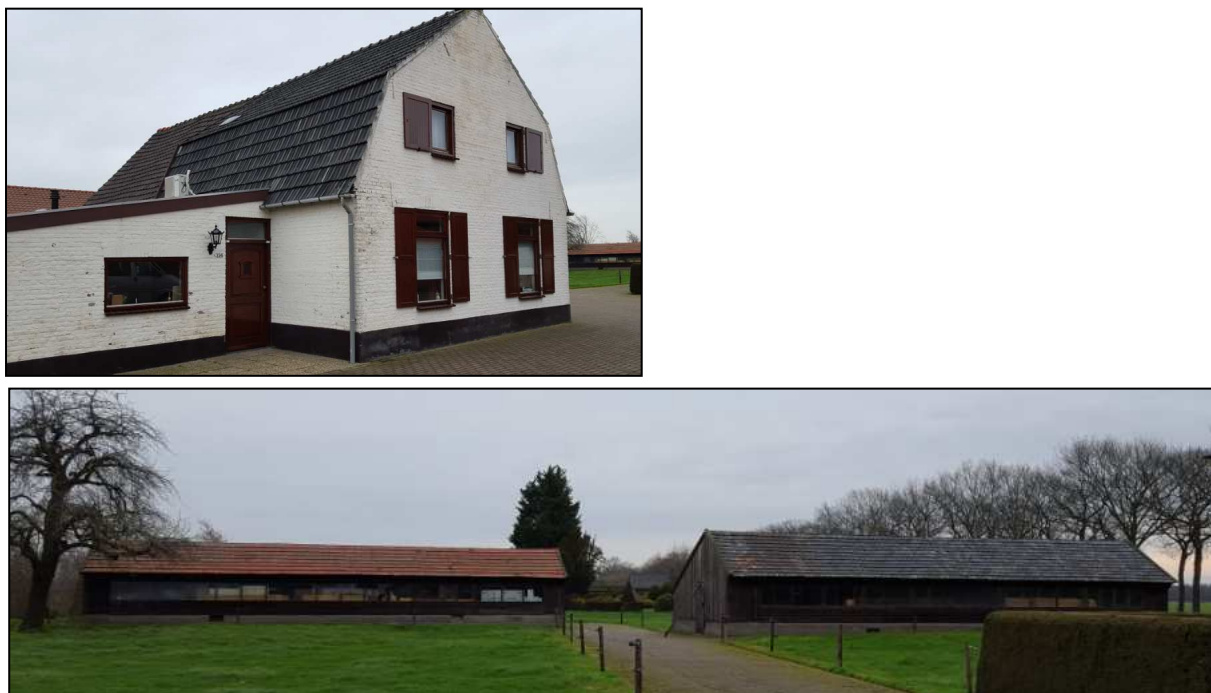
Figuur 26: Te slopen bebouwing binnen het plangebied
