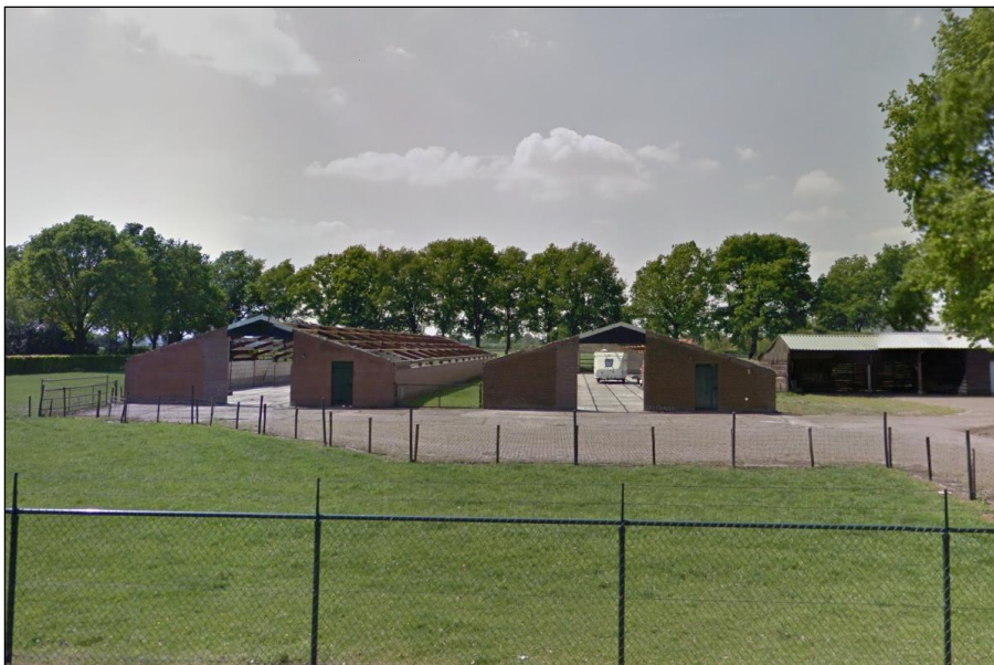
Figuur 5: Situatie tijdens het saneren van de stallen
