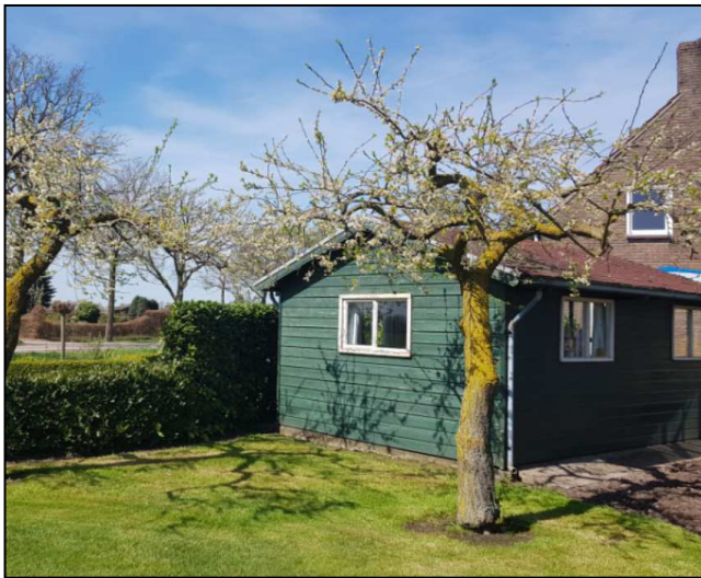
Figuur 9: Beeld van gebouwen (nummer 2 en 3 op de luchtfoto) en tuinhuisje op perceel aan Beliënberkdijk 37 te Someren
