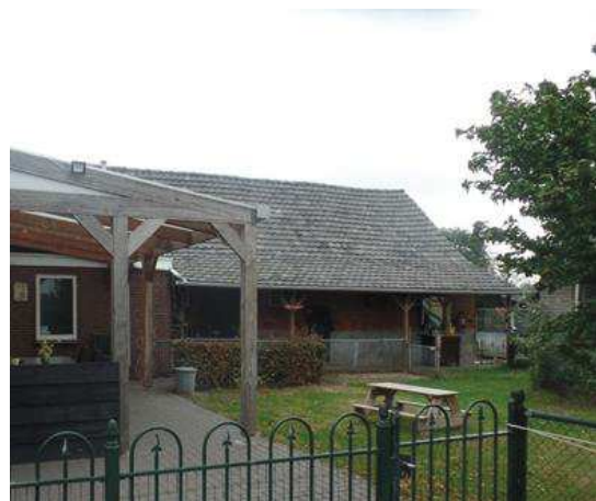
De te slopen schuur van de voorkant gezien
