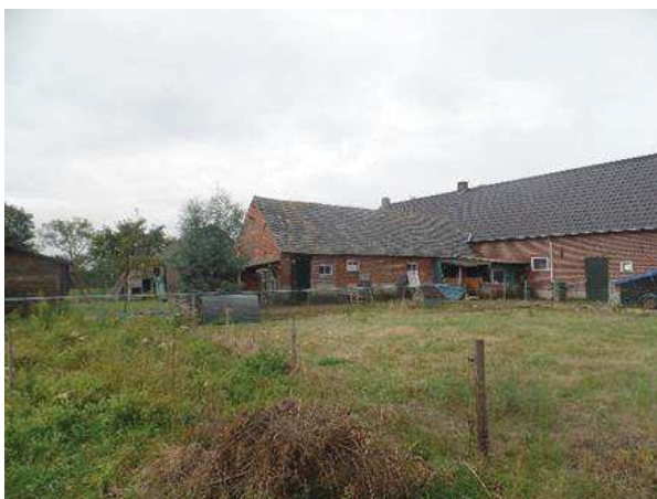
De te slopen schuur van de achterkant gezien
