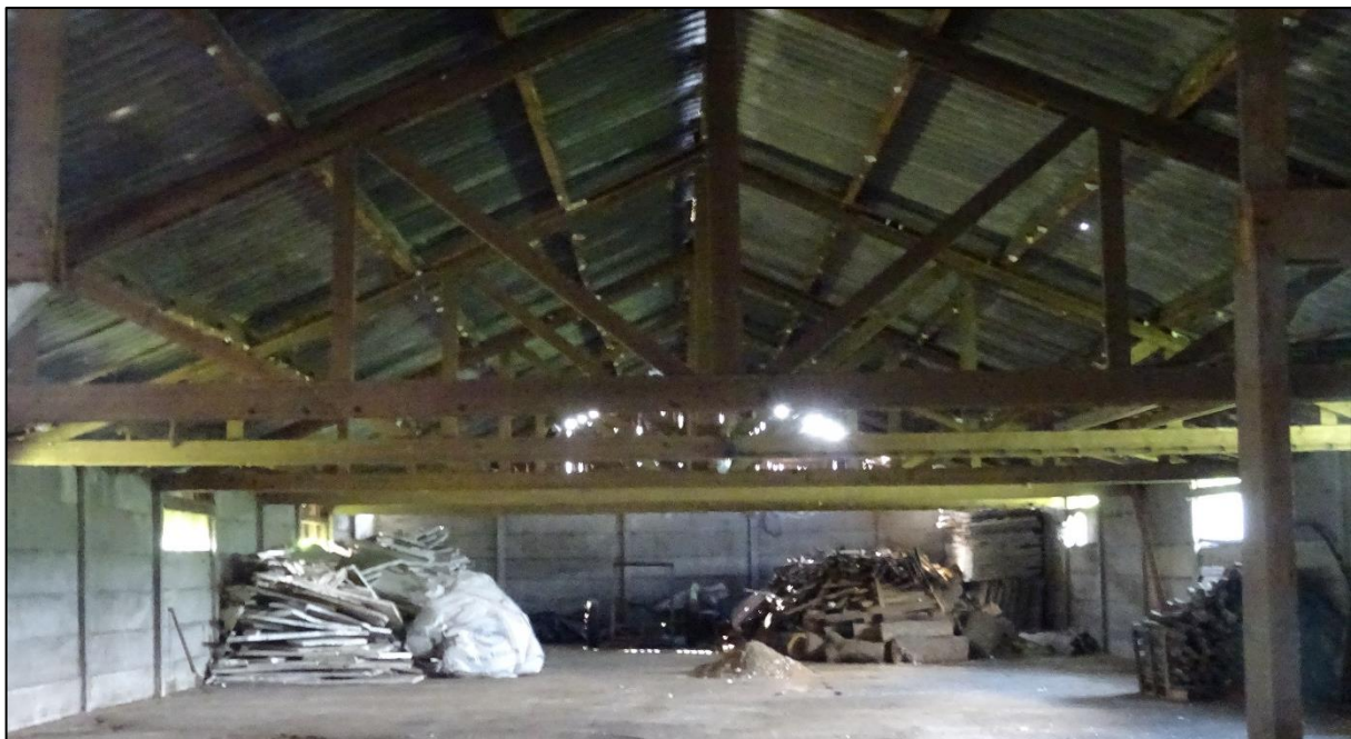
Afbeelding 12. Binnenaanzicht grootste bijgebouw. De schuur is niet geïsoleerd en ook is door de lichtinval duidelijk dat het gebouw in de voor-, achter- en zijgevels niet afgesloten is van de buitenlucht. Deze schuur is al grotendeels leeg en wordt in de komende periode verder leeggehaald in verband met de beoogde sloop.
