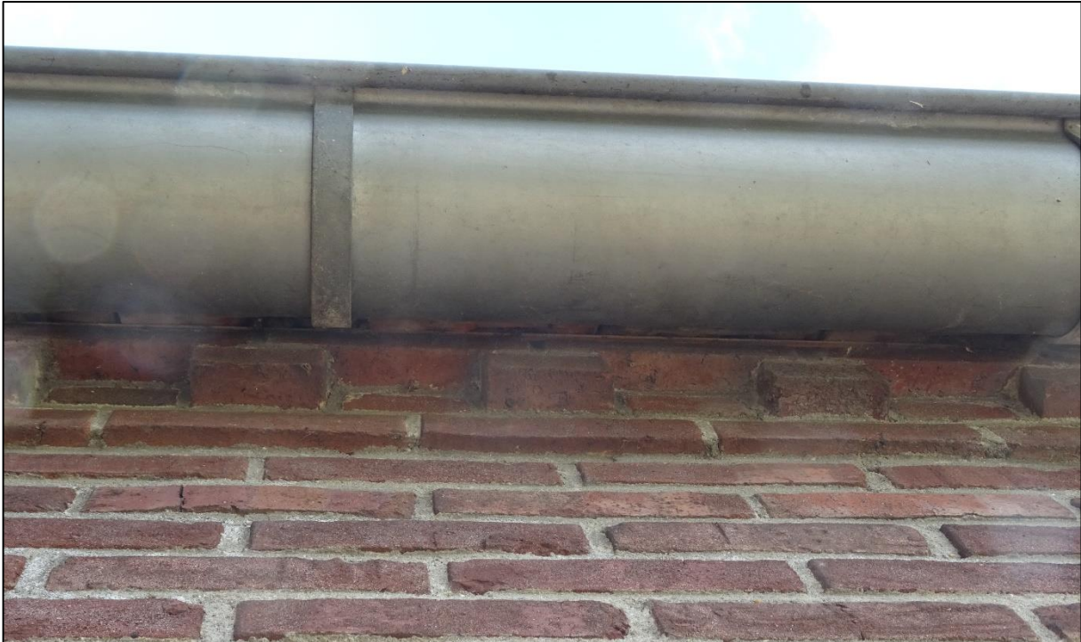
Afbeelding 14. Detail afwerking ter plaatse van dakgoot. De dakpannen liggen ook hier op cementspecie waardoor er geen openingen zijn voor vleermuizen en huismus.
