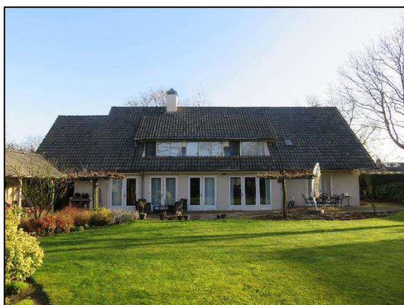
Foto 3. Westzijde van het woonhuis
