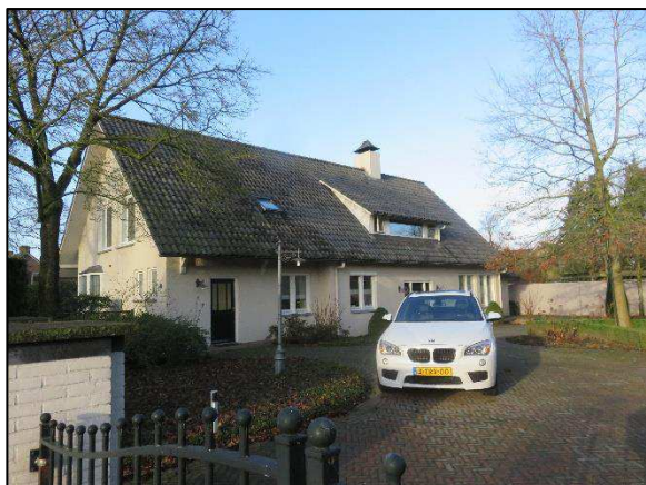
Foto 1. Oostzijde van het woonhuis
