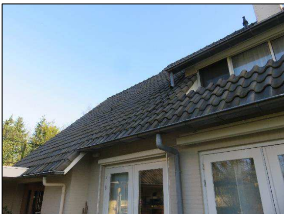
Foto 7. Dakranden van het woonhuis
