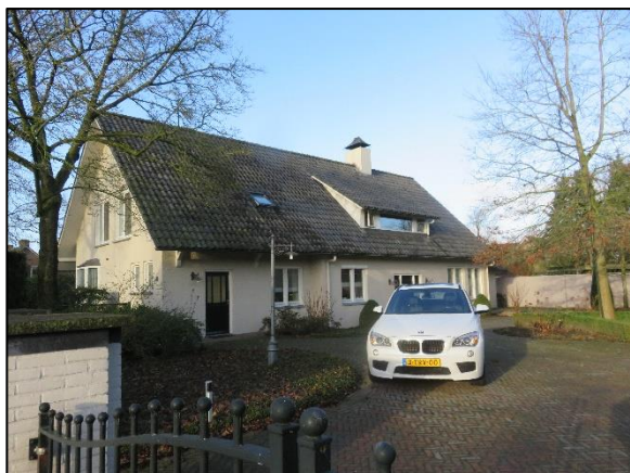
Foto 1. Oostzijde van het woonhuis
