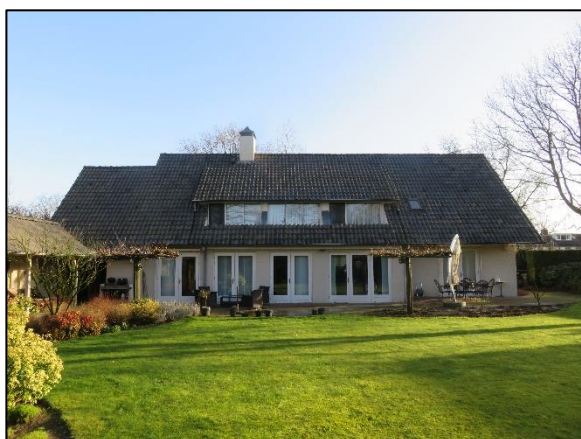
Foto 3. Westzijde van het woonhuis
