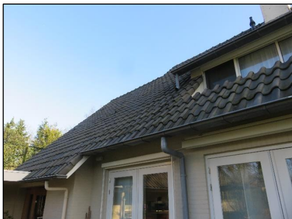
Foto 7. Dakranden van het woonhuis
