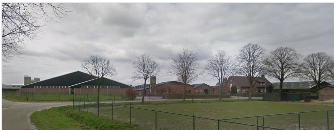
Figuur 7: Huidige situatie locatie Heikomstraat 16 gezien vanaf de Hoeksestraat
