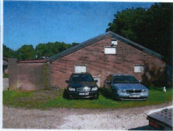
Gebouw A rechter zijgevel
