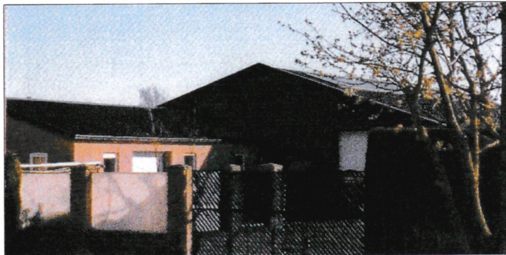
Links bijgebouw B, rechts bijgebouw C
