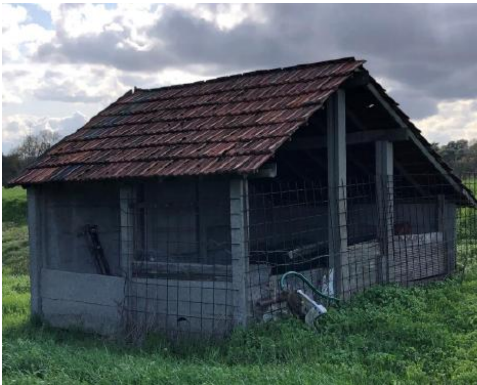
Figuur 4-3: Restant van de bestaande veldschuur
