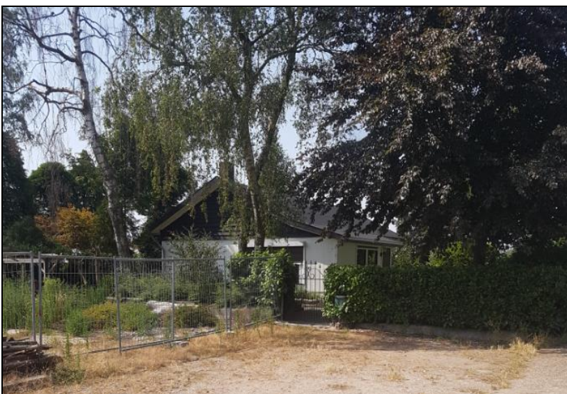
Figuur 8: Bedrijfswoning aan Achterweg 3
