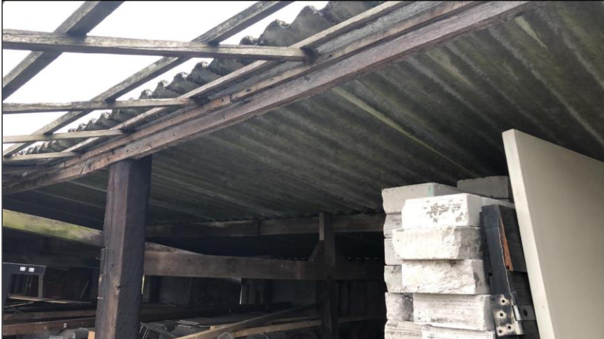
Figuur 19: Dak van het bijgebouw. Het dak is incompleet
