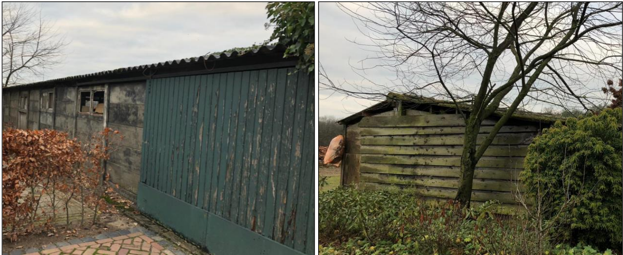
Figuur 18: Te slopen bijgebouw
