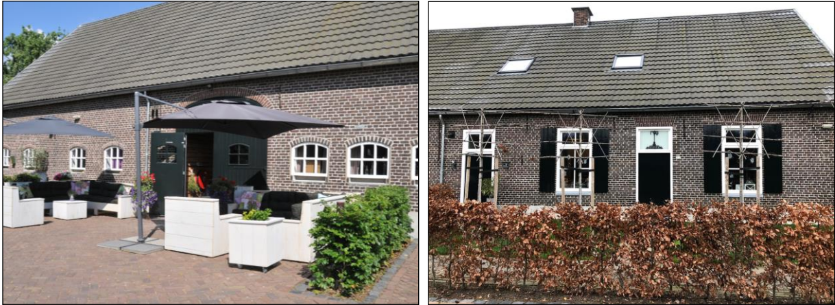
Figuur 5: Stalgedeelte en bedrijfswoning
