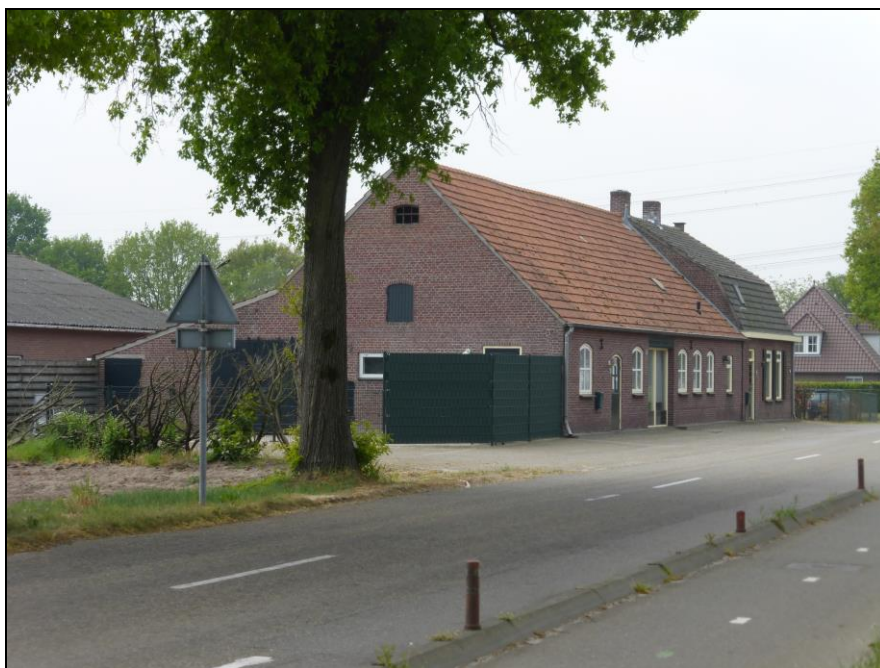
Figuur 6: Langgevelboerderij met twee bedrijfswoningen
