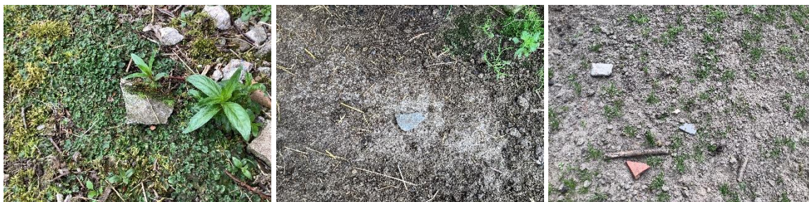
Foto's van asbestverdacht plaatmateriaal op het maaiveld
