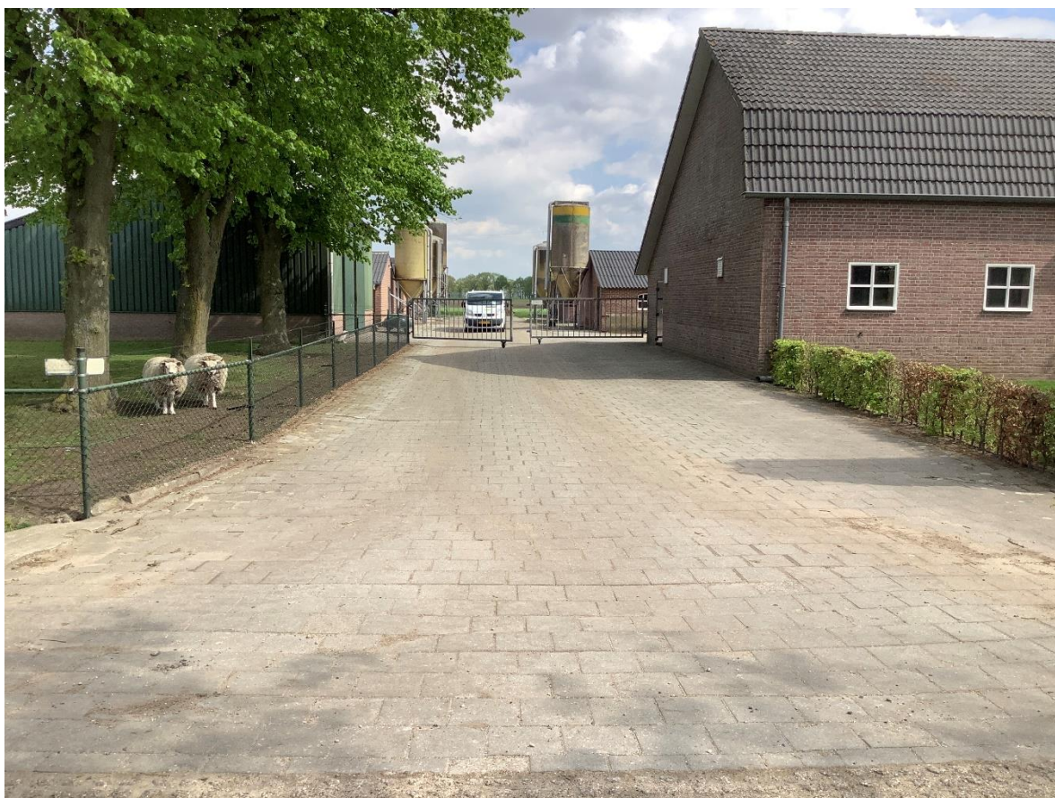
Foto van de oprit van het terrein – d.d. 12 mei 2021
