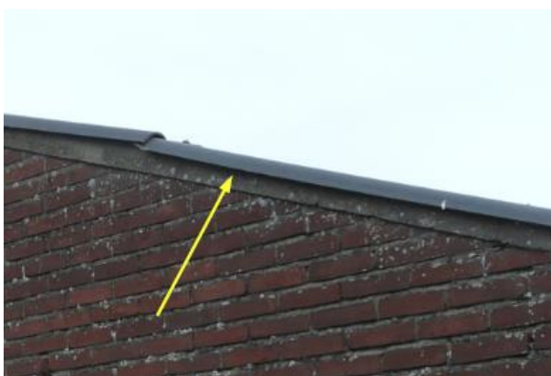
Foto 20 kopgevelafdichting met specierand geb. 30-6
