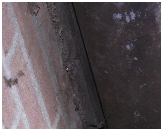
Foto 27 strakke montage goot tegen zijgevel Geb. 40-6
