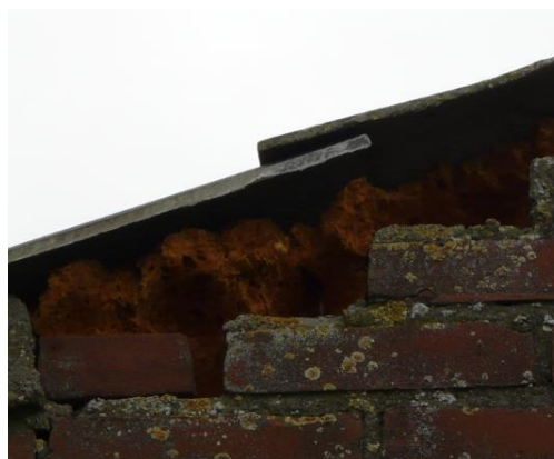
Foto 21 kopg. PUR-afdichting opvulling geb. 30-6
