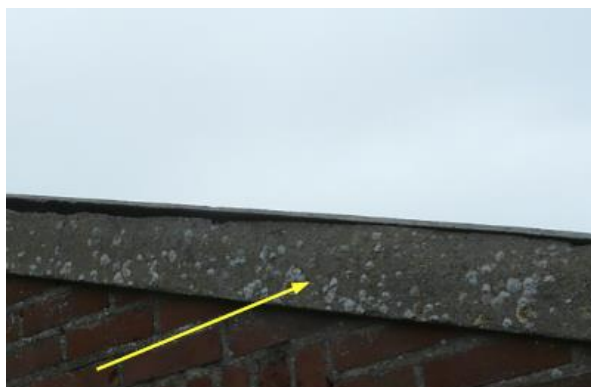
Foto 19 kopg. Afdichting geb. 40-4
