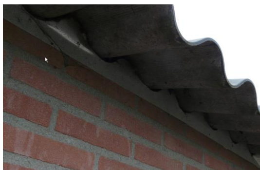
Foto 14 'plaat-golfafdichting' gebouw 40-5
