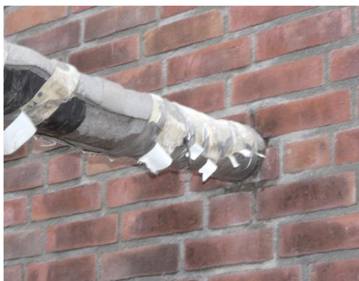
Foto 29 strakke montage pijpdoorvoer Z gevel Geb. 40-7
