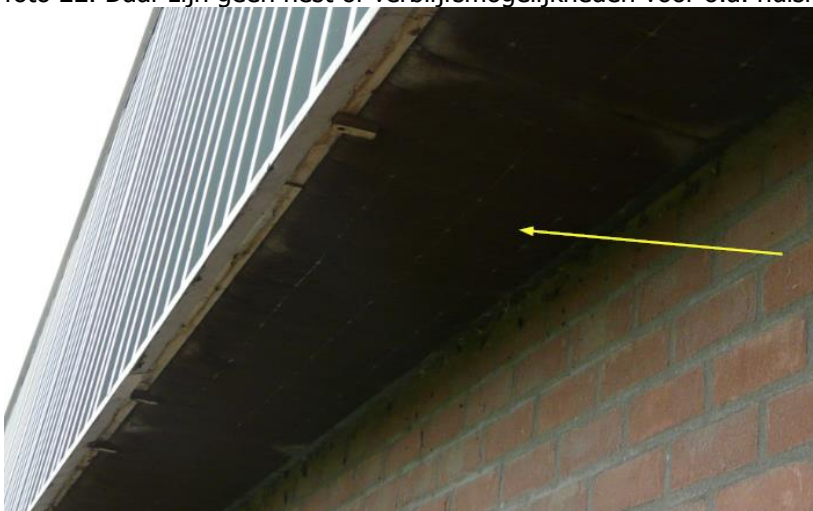
Foto 22 van gaas voorziene luchtinlaat geb. 30-11
