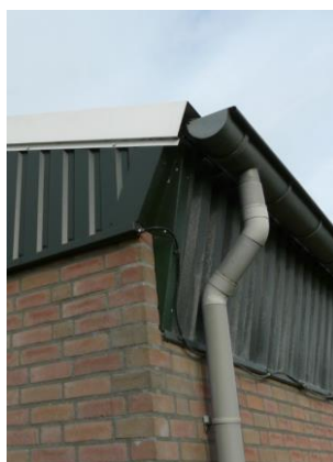
Foto 17 Dichte hoekafwerking geb. 40-8
