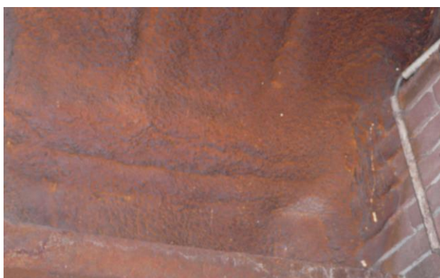
Foto 24 pur tegen dak geb. 40-6
