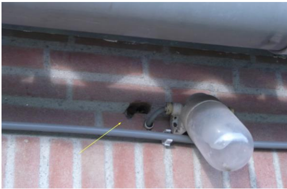
Foto 24 open voeg zonder invliegsporen en met daarin purschuim gevoeld; geb. 40-4
