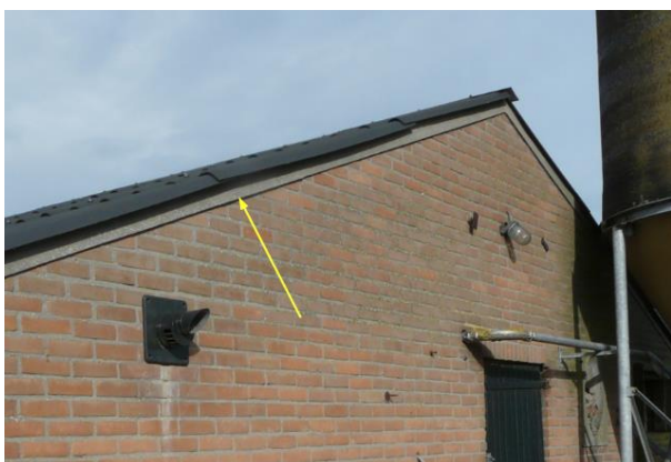
Foto 18 kopgevelafdichting met specierand geb 30-8
