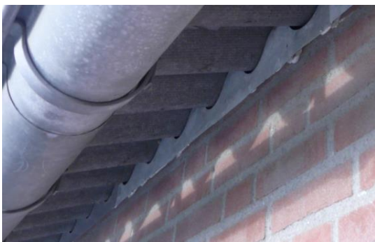
Foto 11 'plaat-golfafdichting' gebouw 40-4
