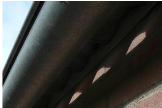
Foto 12 'plaat-golfafdichting' gebouw 30-9
