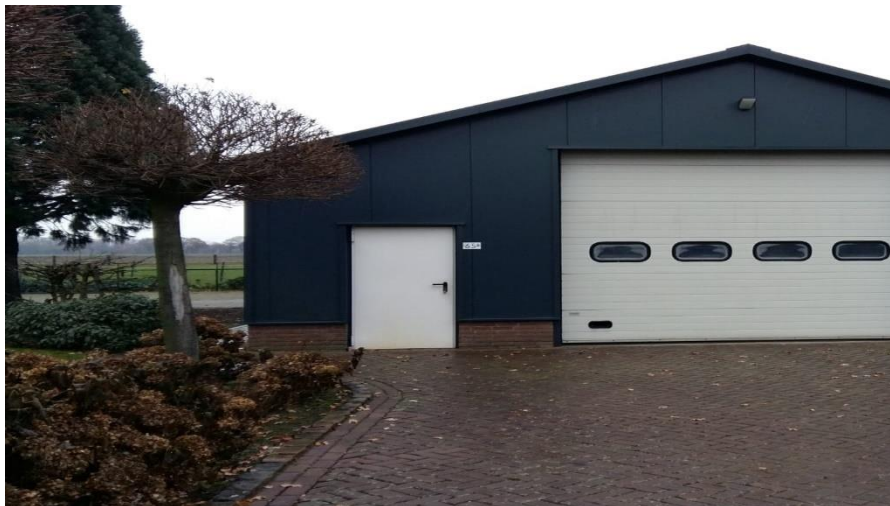
Te slopen bijgebouw
