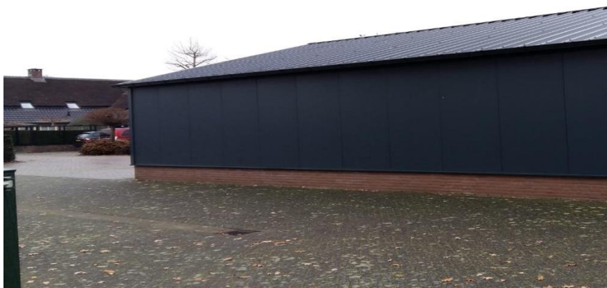
Te slopen bijgebouw (buitenzijde)
