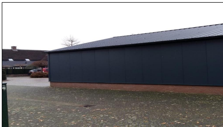
Te slopen bijgebouw 65b (buitenzijde)
