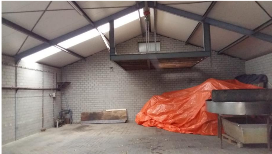
Te slopen bijgebouw (binnenzijde)
