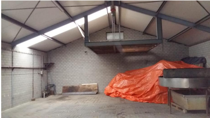
Te slopen bijgebouw (binnenzijde)
