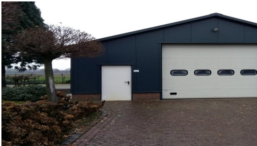
Te slopen bijgebouw
