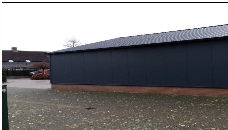
Te slopen bijgebouw 65b (buitenzijde)
