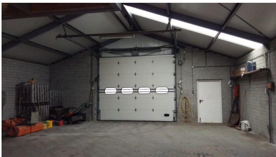
Te slopen bijgebouw (binnenzijde)
