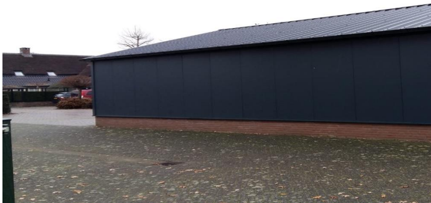
Te slopen bijgebouw (buitenzijde)
