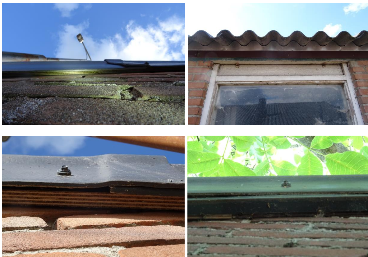
Afbeelding 13 t/m 16: Geen mogelijke vaste rust- en verblijfplaatsen van vleermuizen in de te slopen en verbouwen bebouwingen. Bron: BNL advies. Datum: 30-05-2022
