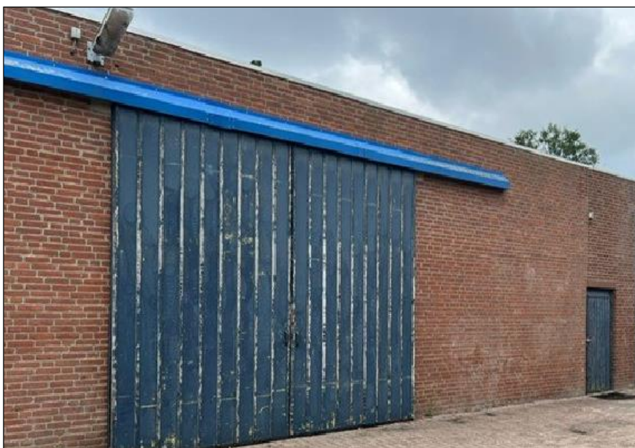
Figuur 20: Afgesloten dakrand
