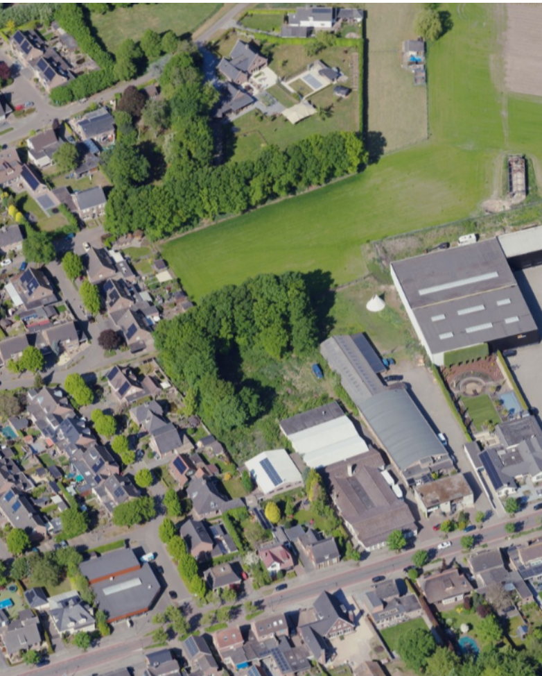
Foto 1 Luchtfoto planlocatie (bron: streetsmart)
