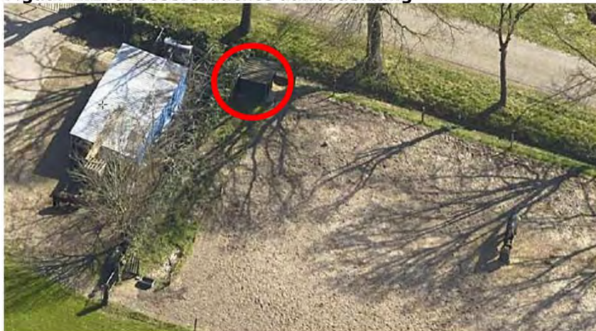
Figuur 2.2: asbestverdachte dakbedekking
