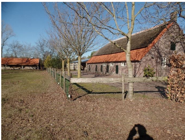
Fig.7 Bijgebouw (wordt niet gesloopt)
