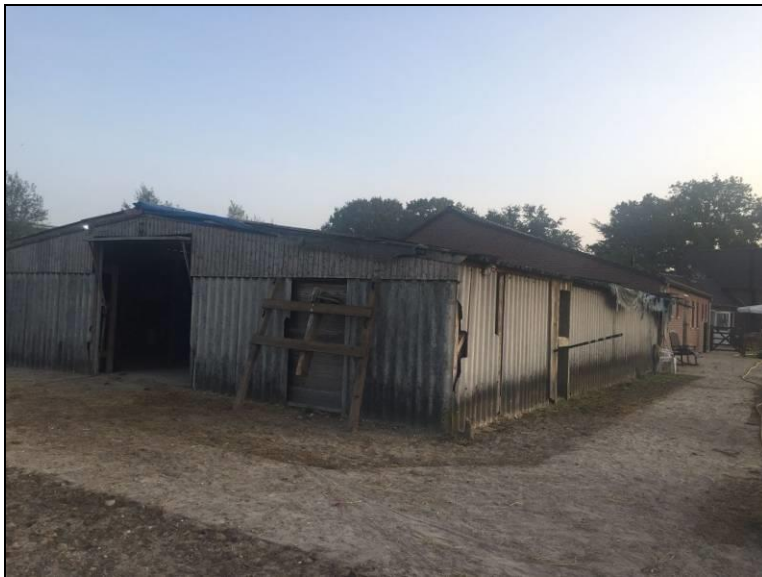
Figuur 5: Foto te slopen stal
