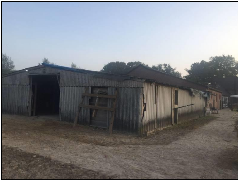
Figuur 5: Foto te slopen stal
