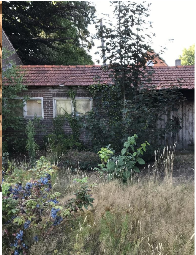
Voorzijde opslag 1 en opslag 2
