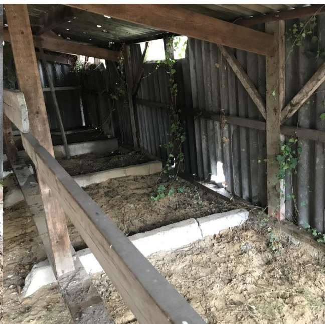
Versie 2 binnenzijde opslag 4
