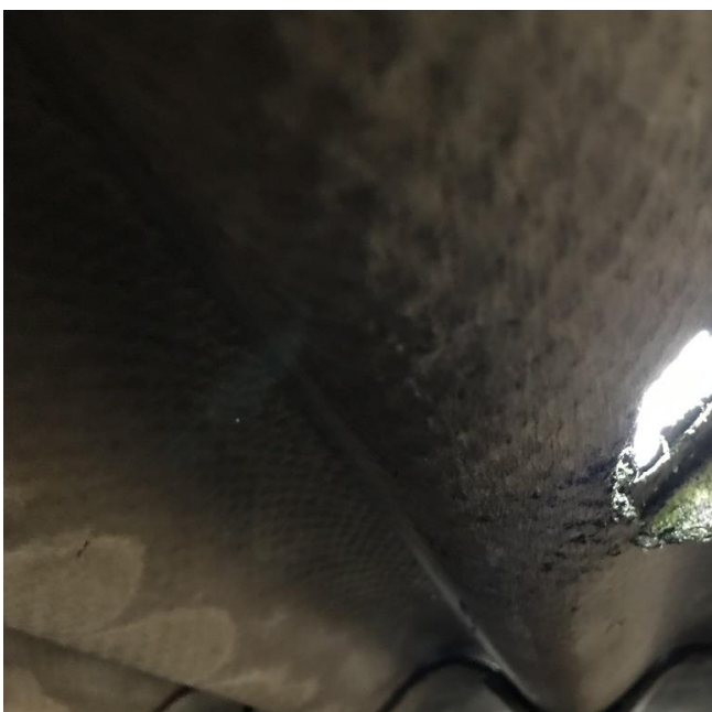
Versie 2 onderzijde dak opslag 4
