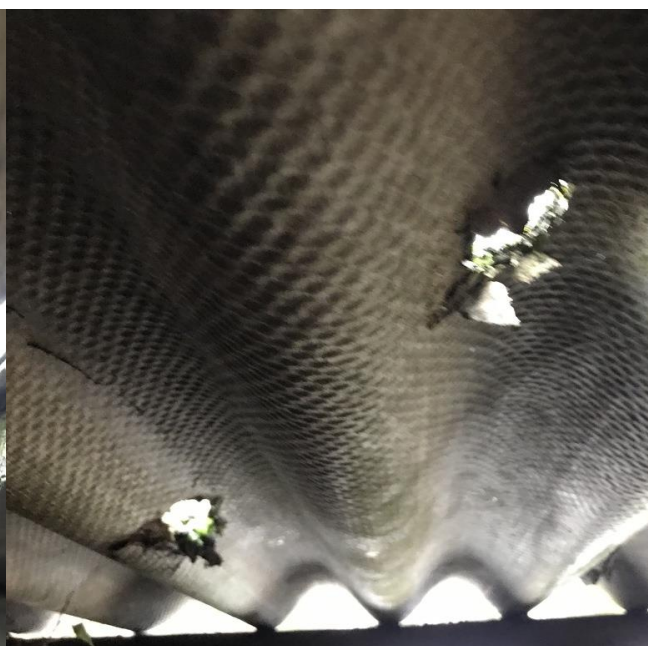
Versie 2 onderzijde dak opslag 4
