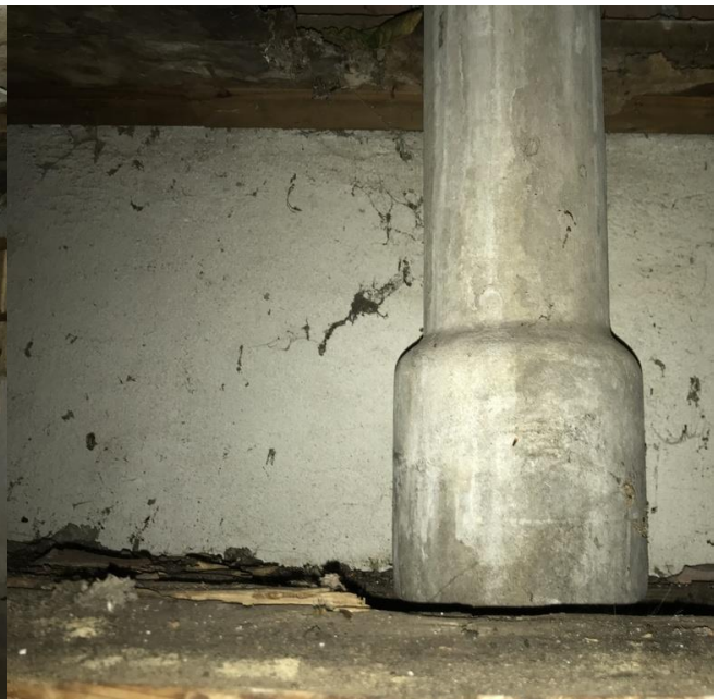
A.c. buis in opslag 1
