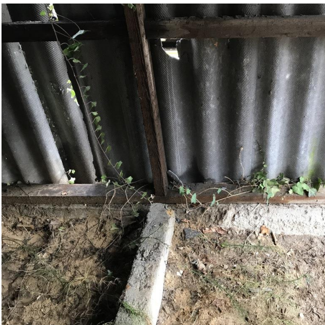
Versie 2 binnenzijde opslag 4
