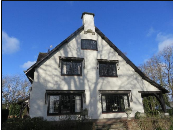
Zicht op de oostgevel van het woonhuis (bron: Staro)
