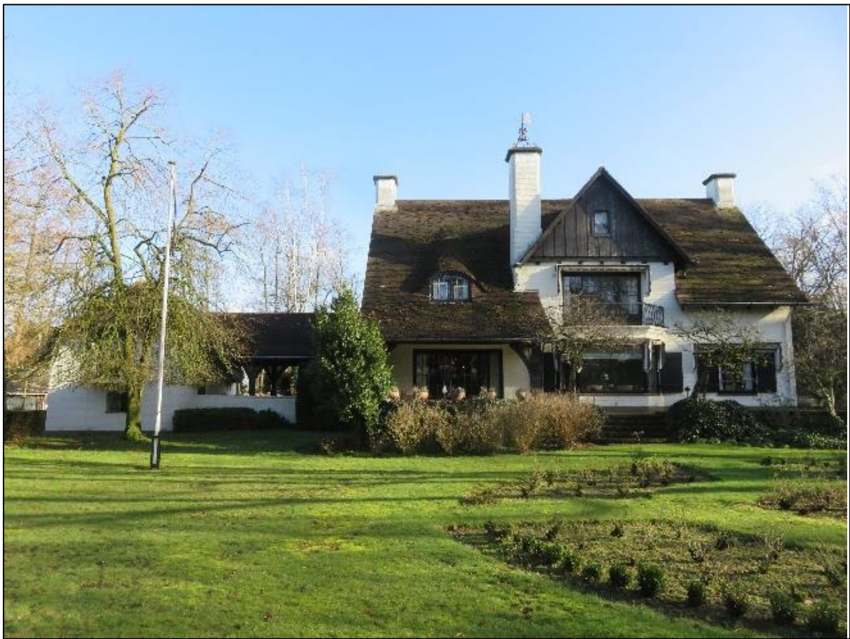
Zicht op voorgevel van het woonhuis Spielheuvellaan 30 (bron: Staro)
