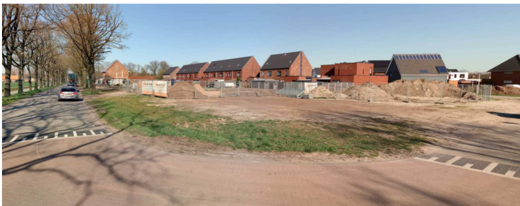
Figuur 3: aanzicht projectgebied vanuit de hoek Somerenseweg - Gildeplein (bron: www.cyclomedia.nl )
