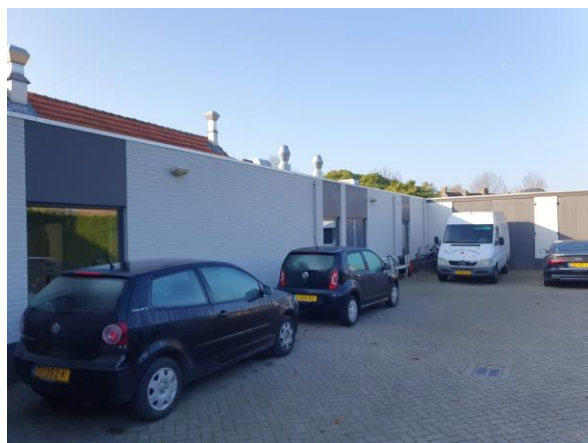
Groot gedeelte van de horecapanden is laagbouw met platte bitumineuze daken. Strak afgewerkte randen met metalen hoeklijnen.
