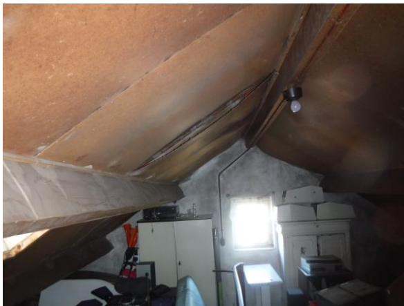
Zolders gebouwen geïnspecteerd.
