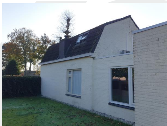
De aanbouw van de woning heeft enkele stootvoegen. Deze zijn laag voor vleermuizen om in te vliegen. Tijdens inspectie blijken deze niet in gebruik te zijn. In de stootvoegen zijn spinnenwebben waarneembaar. Bovendien bevinden zich geen uitwerpselen op de grond.
