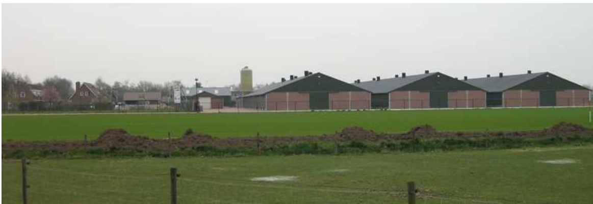
Figuur 1. Huidige situatie projectlocatie
