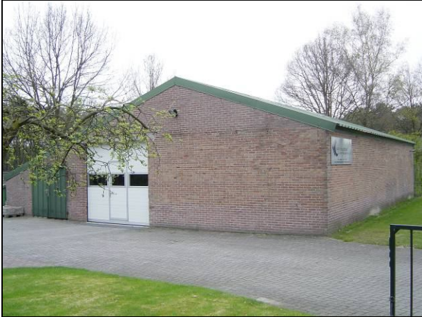
Vooraanzicht terrein met bedrijfsgebouw
