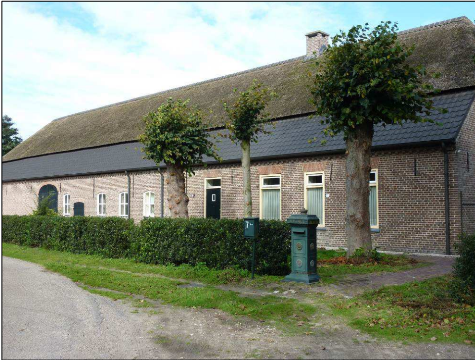
Figuur 5: Langgevelboerderij aan Moorsel 7
