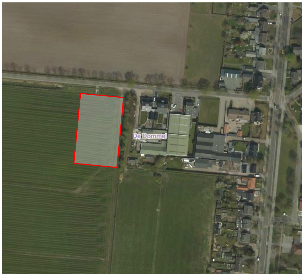
Luchtfoto van de onderzoekslocatie [Bron: risicokaart Noord-Brabant]
