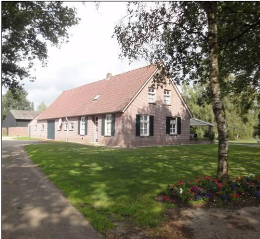
bestaande woning Kuilerstraat 25
