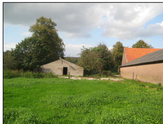
Afbeelding: bestaande stallen
