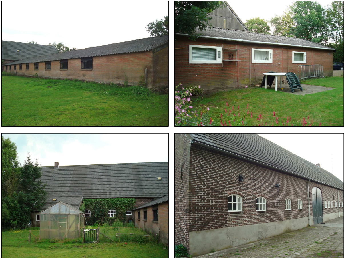
Figuur 28: Uitstraling bebouwing huidige situatie (met de klok mee: loods, vrijstaand bijgebouw, voorzijde woonboerderij, achterzijde woonboerderij)
