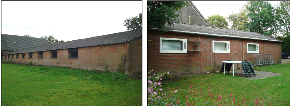
Figuur 25: Huidige uitstraling bijgebouwen (links: aangebouwd, rechts: vrijstaand)
