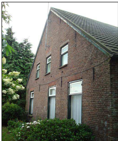
Figuur 22: Oostelijke zijgevel
