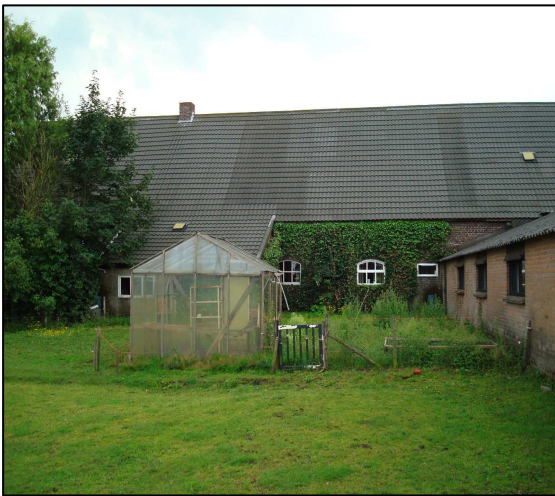
Figuur 24: Achterzijde hoofdgebouw met te slopen aanbouw
