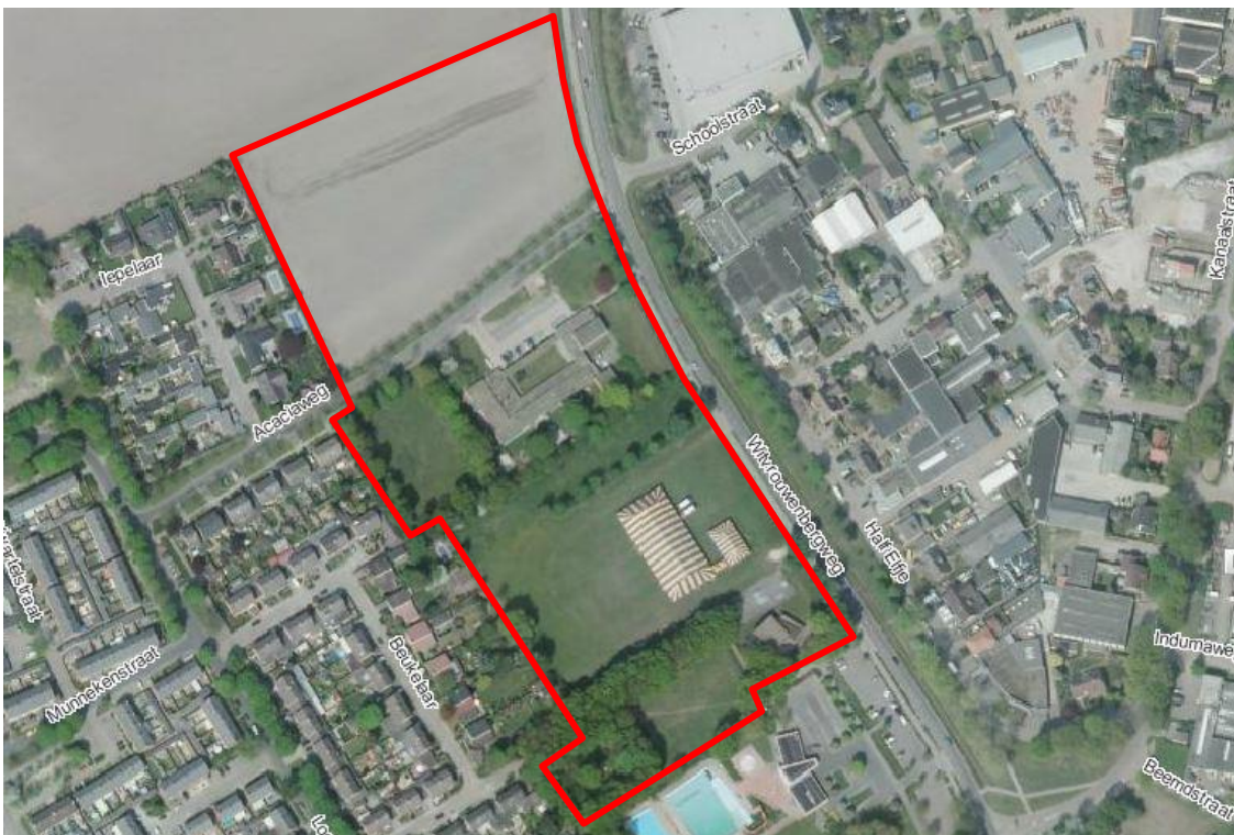
Luchtfoto van de onderzoekslocatie [Bron: risicokaart Noord-Brabant]
